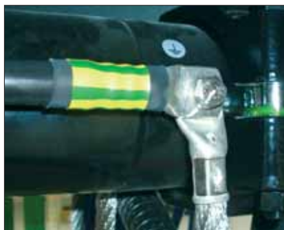
La gaine TF21 vert et jaune assure une protection longue durée des cosse de câble et permet de repérer clairement les câbles de masse.
