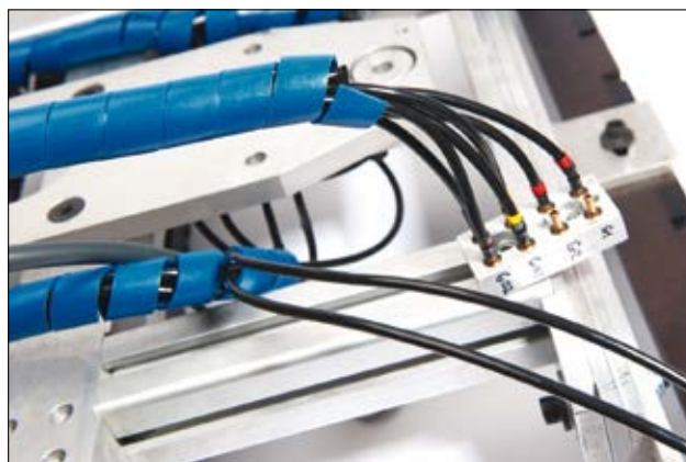
Réduisez le risque inhérent de contamination des produits fabriqués dans votre usine.
