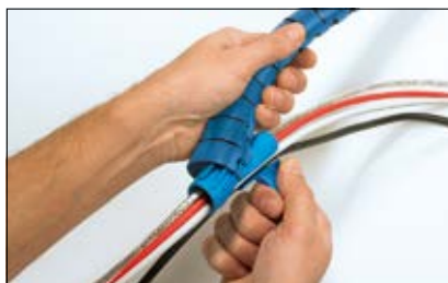
2- Placez l'outil d'installation à une extrémité de la gaine.
