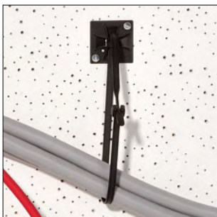
Het dunne bandeinde in de sluitkop leggen en door terugtrekken vergrendelen.
