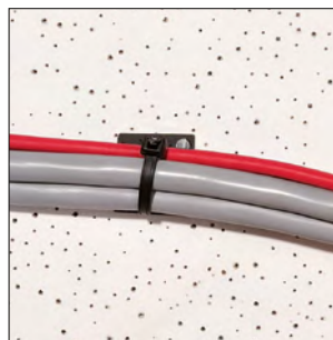
Na het afronden van het installeren wordt de Q-tie als gebruikelijk aangetrokken en afgebonden.
