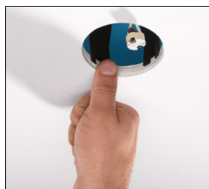
Enfoncer les ergots dans la plaque de plâtre pour éviter tout glissement.
