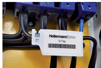
Le marquage des plaquettes Q-tags peut être réalisé avec des étiquettes imprimées ou à la main.
