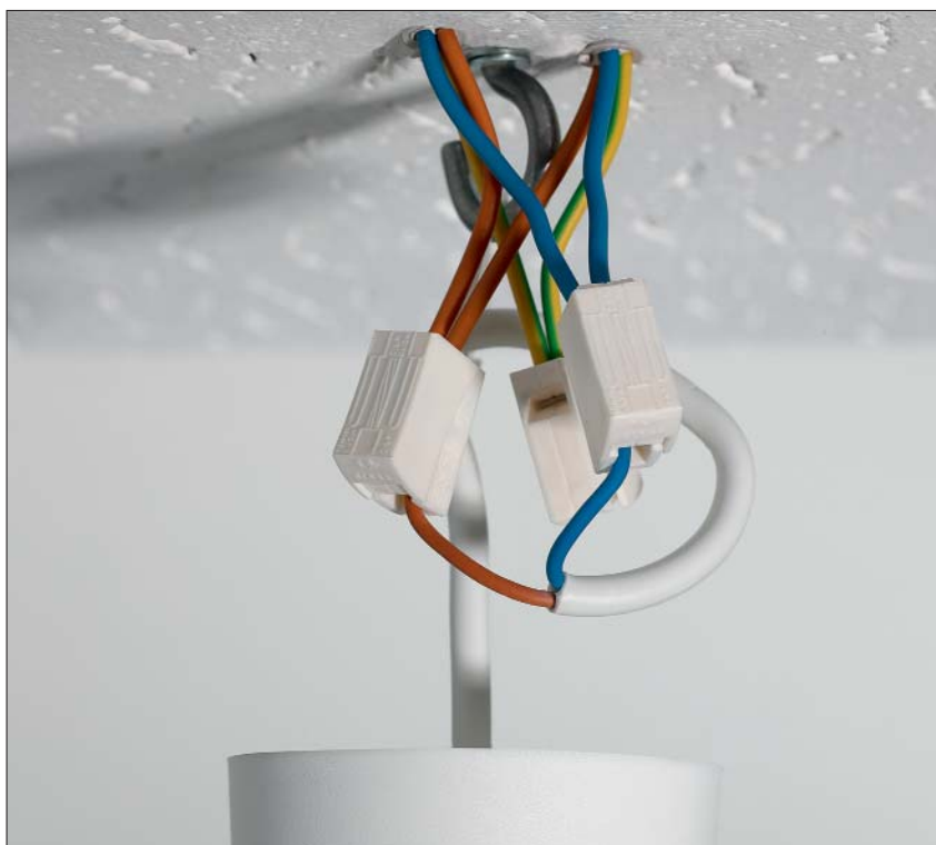
Installation rapide et démontage possible des équipements avec les bornes HelaCon Lux.
