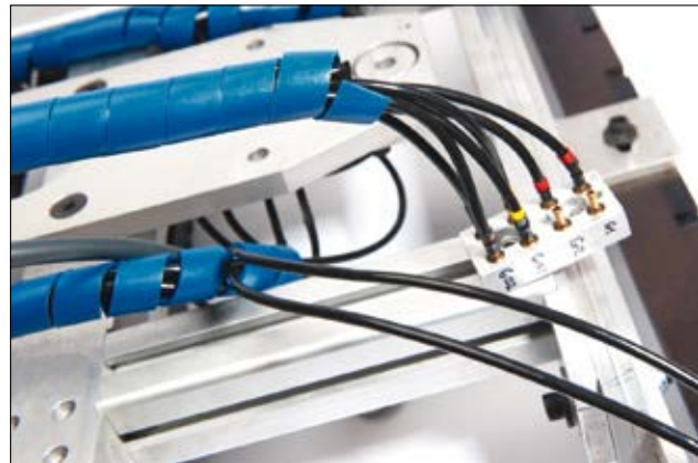
Detecteerbare, metaalhoudende spiraalslang beschermt bekabeling in levensmiddelenapplicaties.
