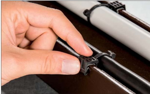
Mise en place du support EdgeClip sur une poutrelle, par enfoncement.
